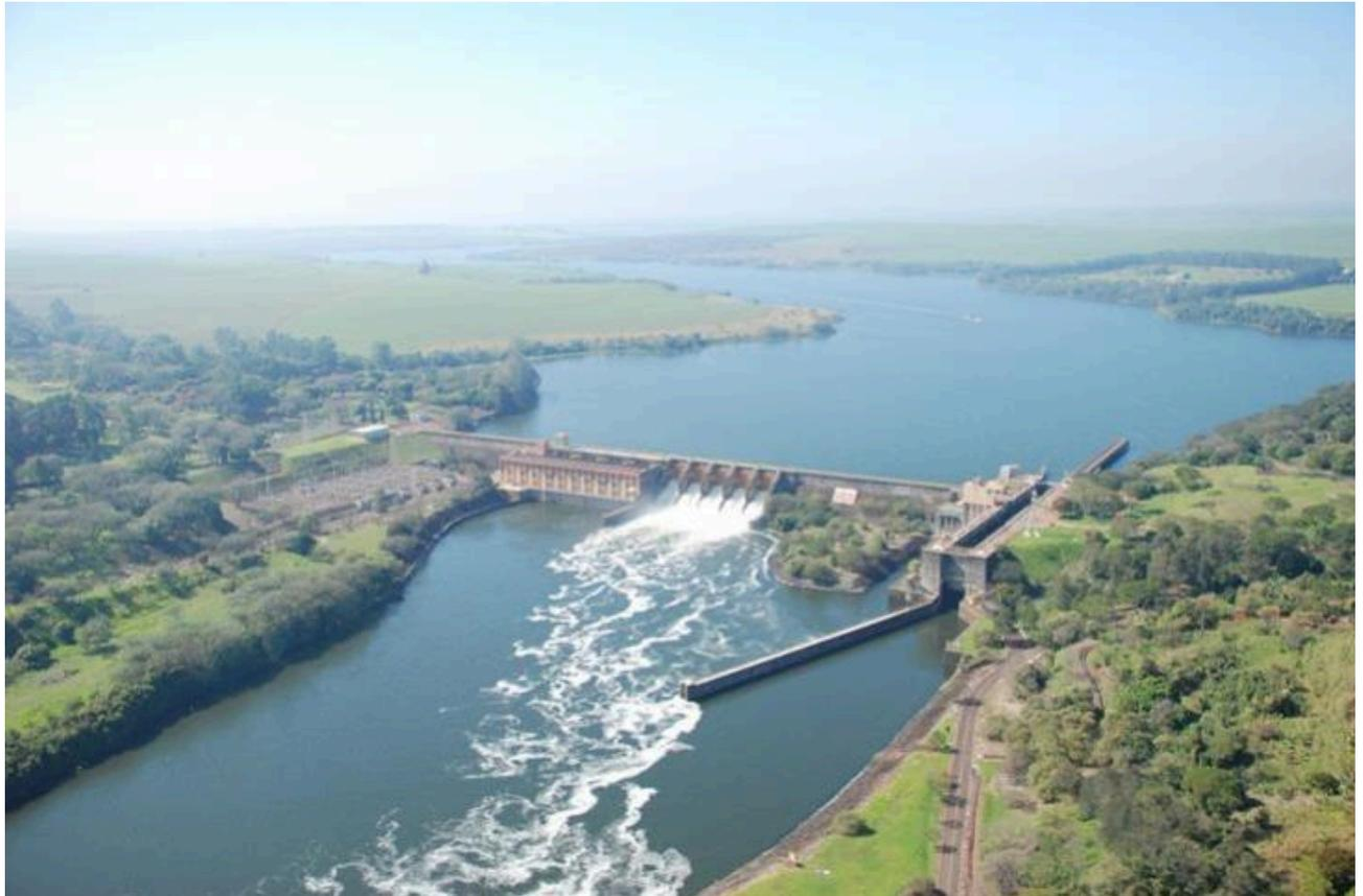
*UHE Barra Bonita com 140 MW, hidrovía do Tietê, com eclusa de 12 metros largura igual à da UHE Boa Esperança*
